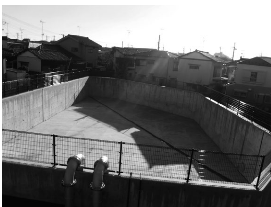
南初富2丁目雨水貯留池
