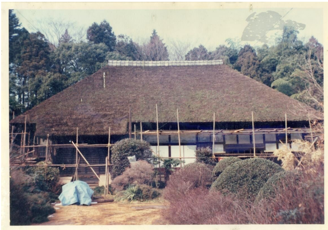
「澁谷家 母屋屋根葺替前」 鎌ヶ谷市所蔵 昭和52年（1977年）11月頃
