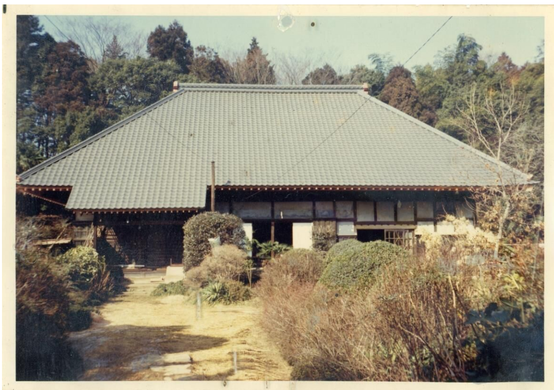
「澁谷家 母屋屋根葺替後」 鎌ヶ谷市所蔵 昭和53年（1978年）1月
