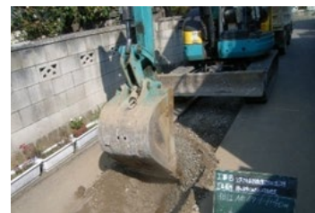
公共下水道整備工事
