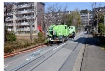
下水道管路の清掃作業
