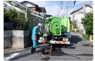
管路点検、調査の様子
