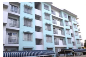
外壁、屋上防水改修を実施した 栗野市営住宅
