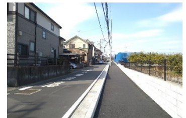
設置した歩道
