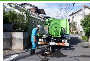
管路点検、調査の様子
