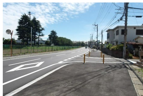
改良した市道
