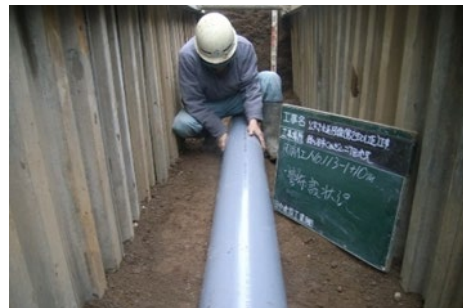
管路布設工事
