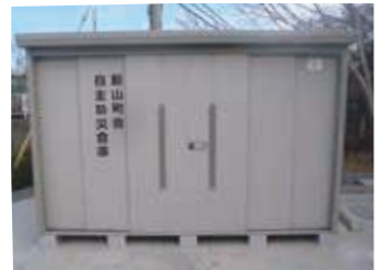
防災倉庫が整備され、防災力が向上
