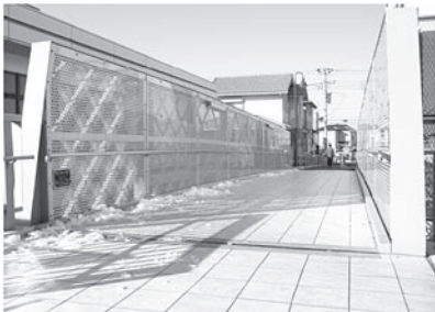
新鎌ヶ谷駅北口歩道橋
