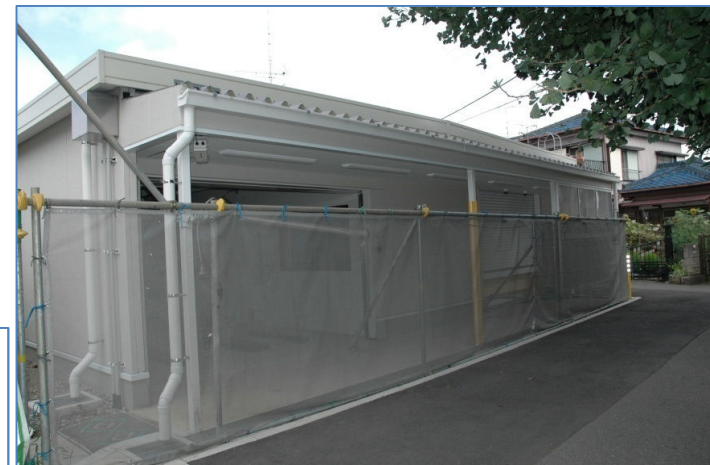
工事中の仮駅舎
