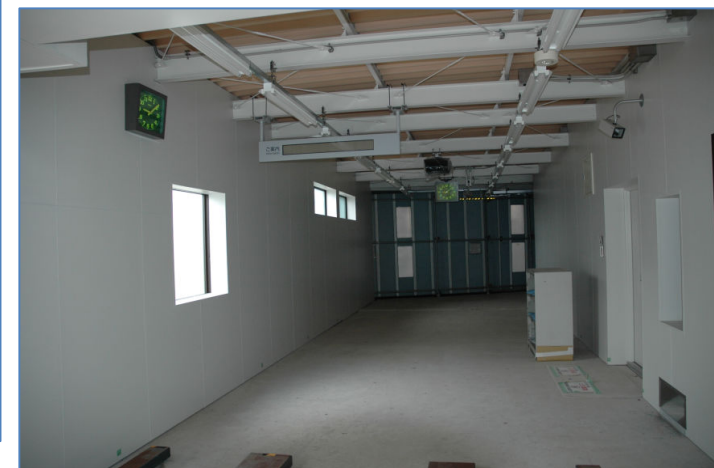
工事中の仮駅舎内部
