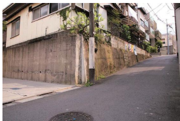
擁壁や坂 に面する
