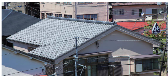
健全な瓦屋根
