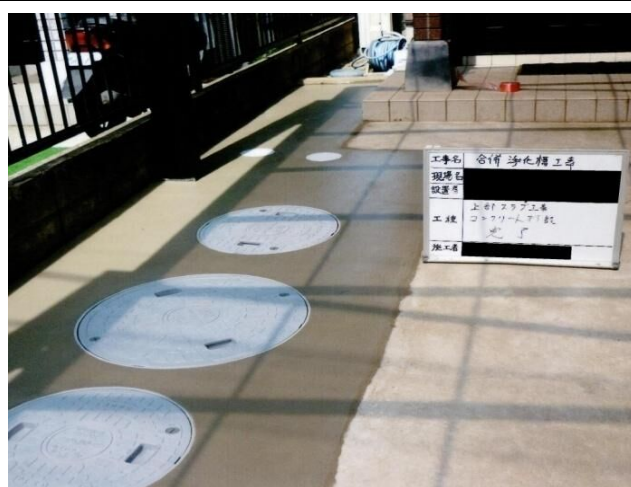
18. 合併処理浄化槽完了後
