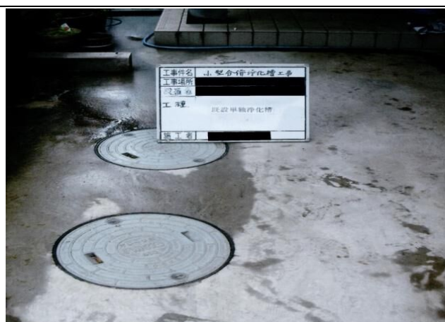
19. 既設単独処理浄化槽又はくみ取り便槽の全景
