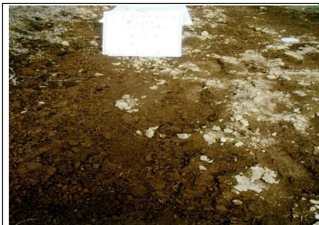
26. 既存し尿施設の撤去後
