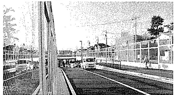
市川インターに直結する浦安鎌ヶ谷線(市川市内)。この道路につながる道路整備が必要
