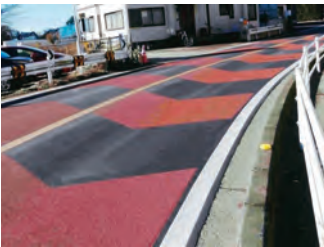
道路維持補修（市道28号線）
