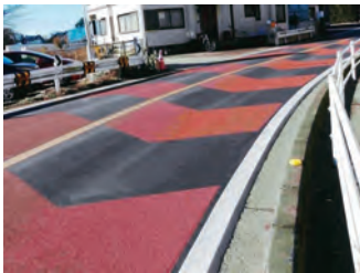
道路維持補修（市道28号線）
