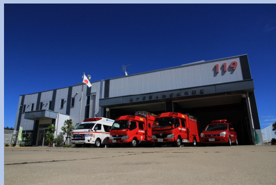
くぬぎ山消防署の完成（建て替え）
