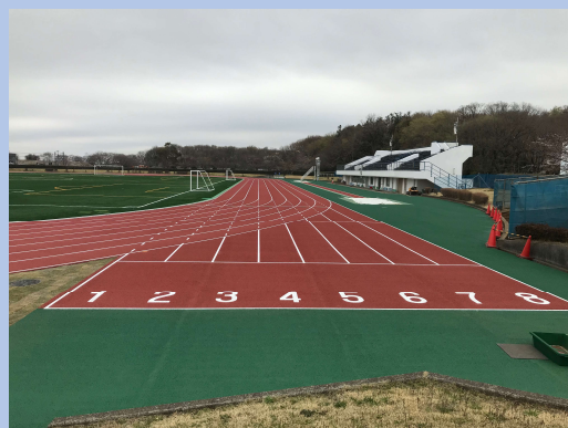
陸上競技場の改修（フィールド・トラック改修）
