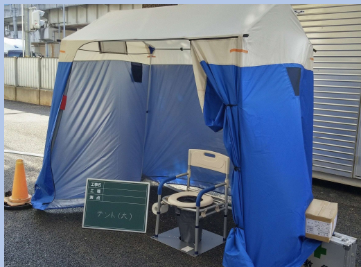
マンホールトイレの設置
