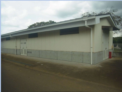
市民体育館の防災倉庫
