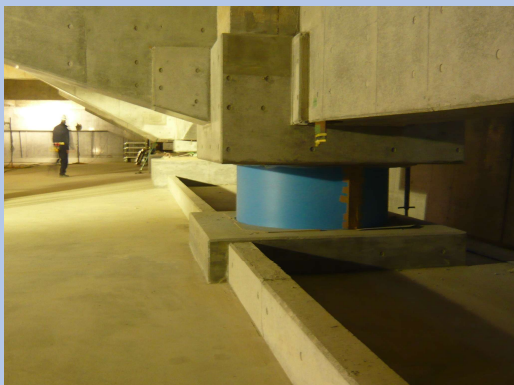
市庁舎免震工事
