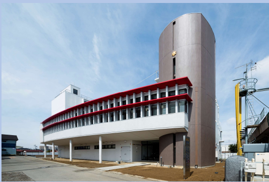
消防本部庁舎の完成（建て替え）
