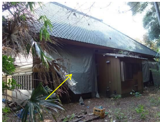
応急修理の状況（西面）
