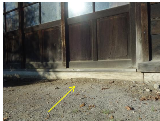
土が被った土台（東面）
