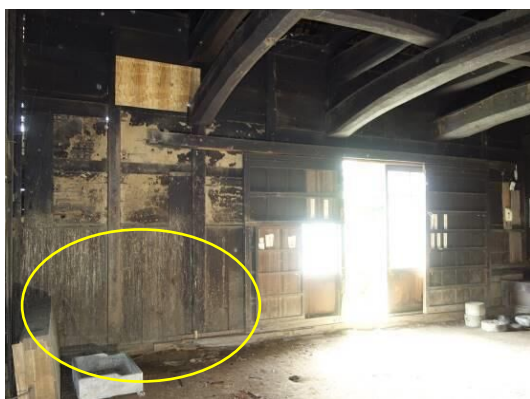
板壁の汚損（左：ドマ（手前）の東側 右：ドマ（手前）の北側）
