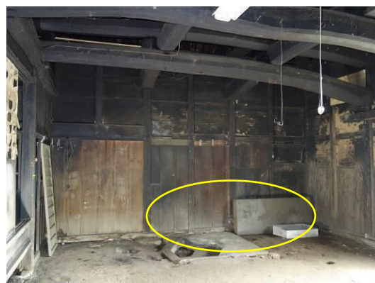
板壁の汚損（左：ドマ（手前）の東側 右：ドマ（手前）の北側）
