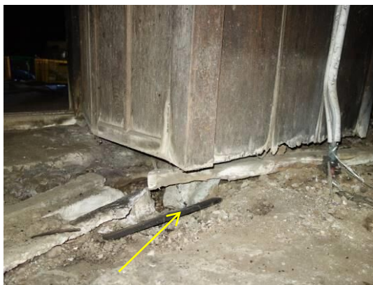
フロの欠失した基礎石（北西隅）
