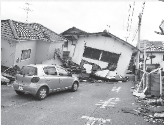
熊本県益城町の被害
