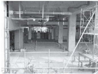
新鎌ヶ谷高架駅舎のコンコース入口と連絡通路(工事中)
