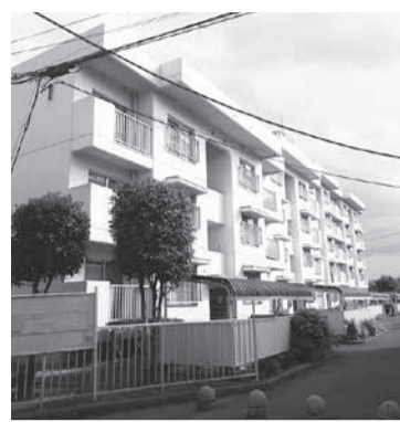
栗野市営住宅 1号棟
