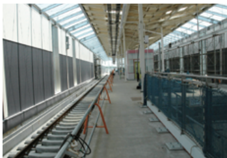
工事中的新鎌ヶ谷駅高架ホーム
