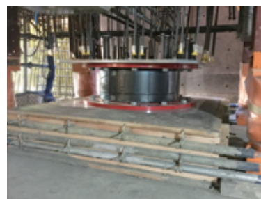
免震装置基礎の施工
