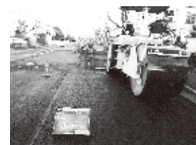
市道の路面・舗装改修
