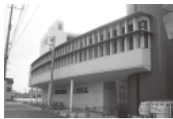
消防本部庁舎
