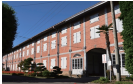
富岡製糸場東繭倉庫
