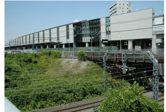
新鎌ヶ谷駅の外観
