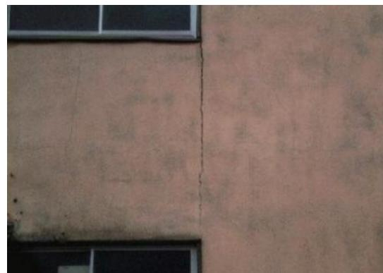
写真Ⅱ.2.2.5 モルタル外壁に生じた大きなひび割れ
