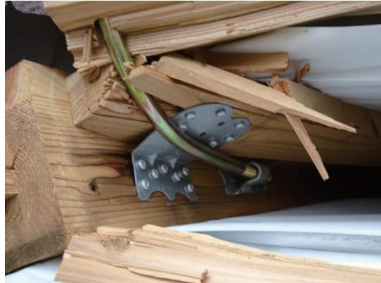
写真 5 写真 4 の建物の写真筋かい端部、
