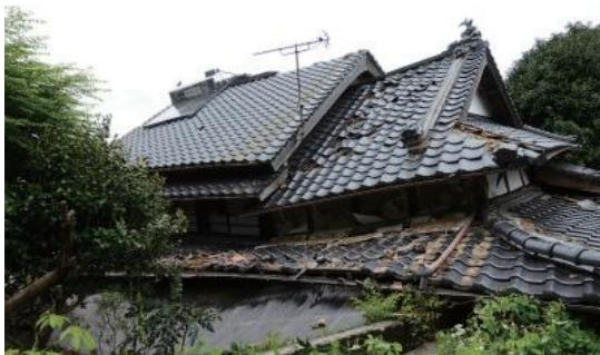
写真8 倒壊した木造住宅
