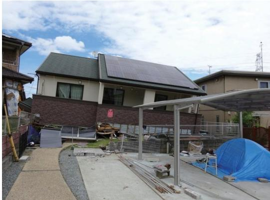
写真 4 倒壊した木造住宅
