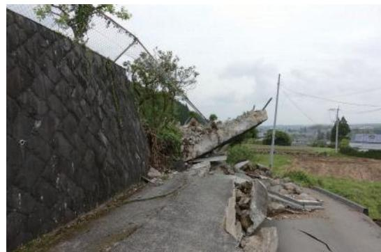
写真11 崩壊した擁壁
