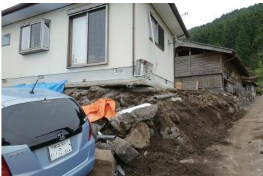
写真10 崩壊した擁壁
