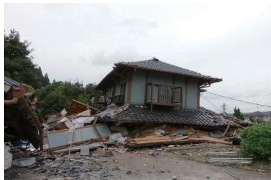
写真9 倒壊した木造住宅
