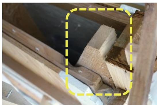
写真 13 写真 12 のアパートの筋かい端部
