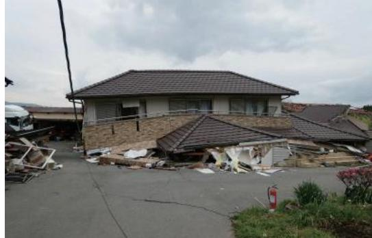
写真 16 倒壊した木造住宅
