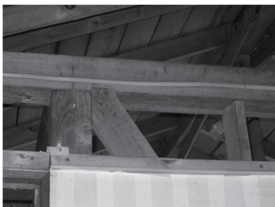
写真 II.2.2.3 柱頭接合部の例
