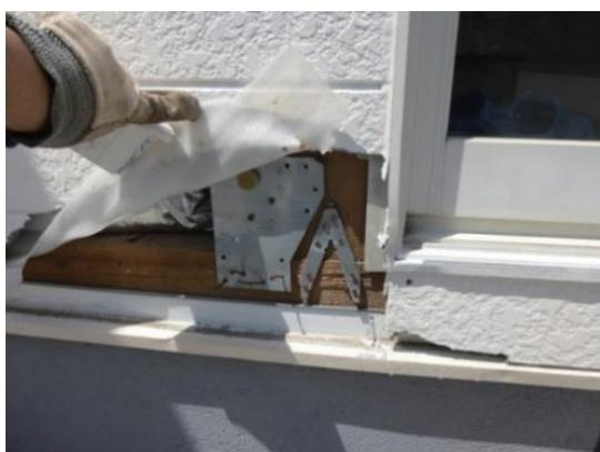
写真 II.2.2.1 柱脚接合部の例
