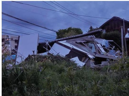
写真 2 倒壊した木造住宅
