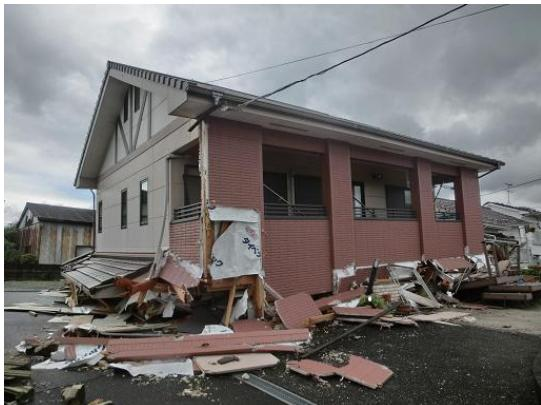
写真 6 倒壊した木造住宅
