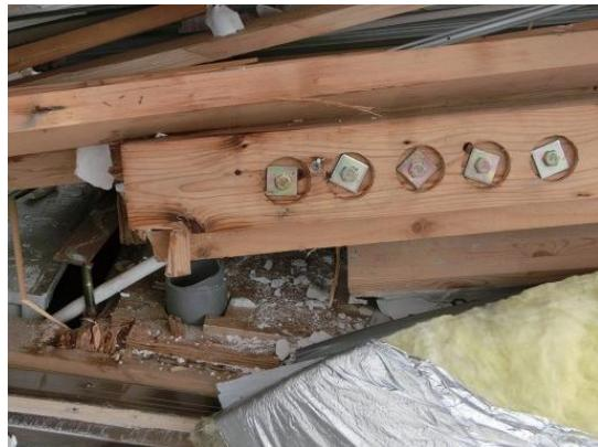
写真 7 写真 6 の建物の写真筋かい端部、
