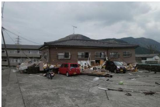
写真 14 倒壊した木造アパート
