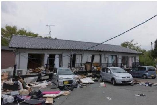
写真 12 倒壊した木造アパート
